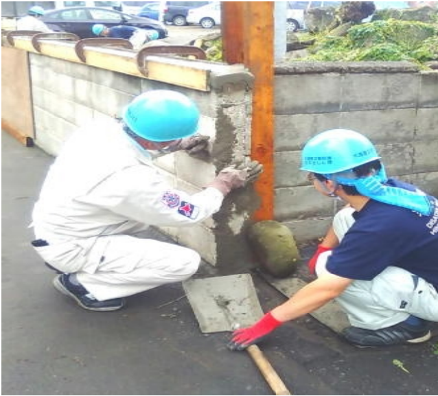
部分補修チーム。
